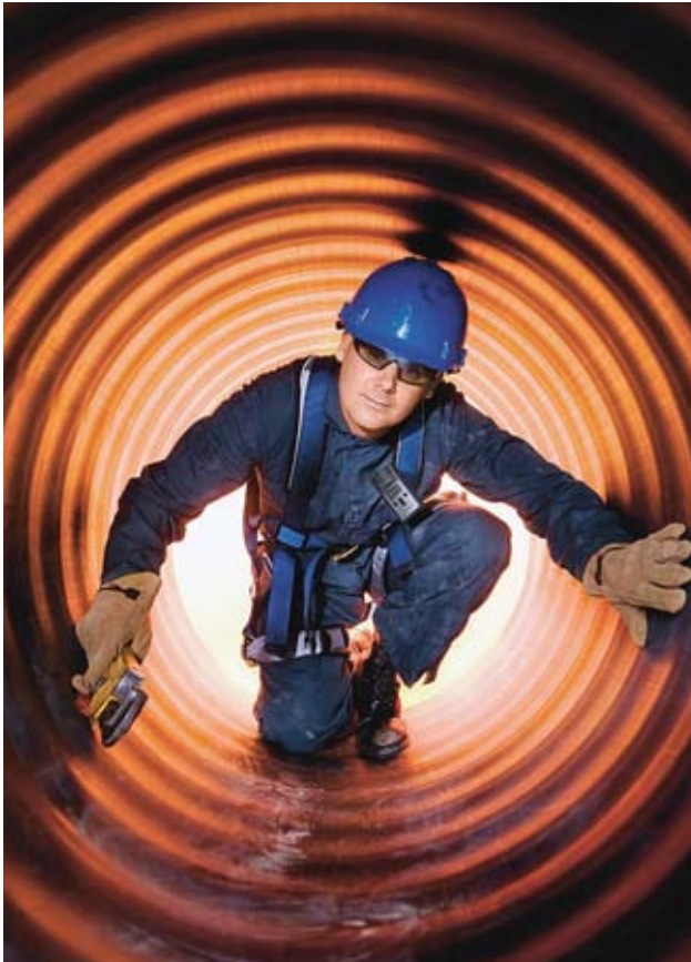
Bei Arbeiten in engen Räumen muss die eingestiegene Person dauernd überwacht werden.
