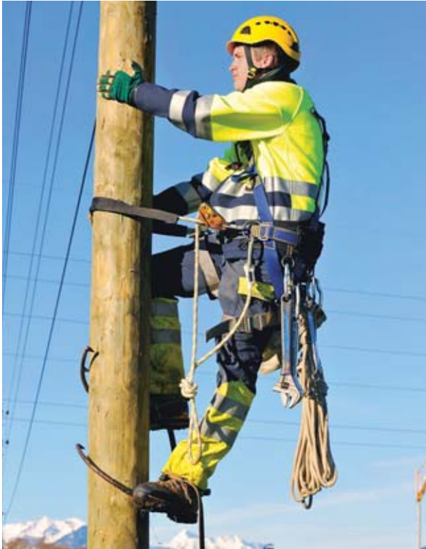
Freileitungsmonteur bei der Arbeit.
